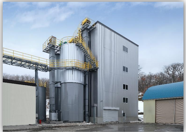
【粒状肥料を製造する新工場】
