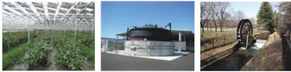
農地に設置された宮農型太陽光発電施設 有機物処理のためのメタン発酵処理施設 農業用水路に設置された小水力発電施設
