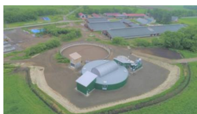
【バイオガスプラント全景】
