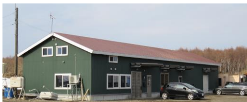
株式会社シンクリッチ 外観
