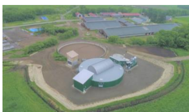
バイオガスプラント
