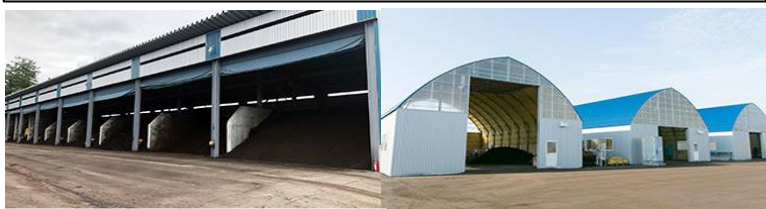
バイオマスセンター発酵槽(中標津町)
