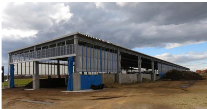
自動堆肥化クレーンシステム外観
