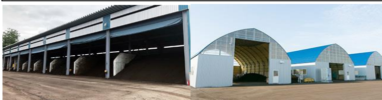
バイオマスセンター発酵槽(中標津町)
