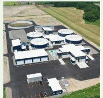
バイオガスプラント (令和7年10月稼働)
