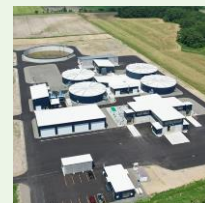
バイオガスプラント (令和7年10月稼働)
