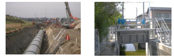
水路のパイプライン化
