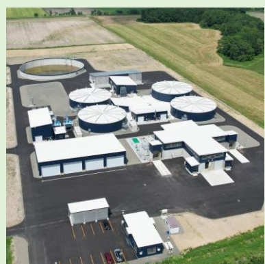
バイオガスプラント全景 (R7年10月から本格稼働)
