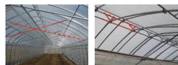
クロスタイバー ダブルアーチ構造 耐雪強度UP↑
