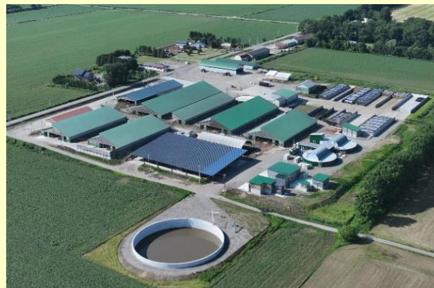
完成したバイオガスプラント
