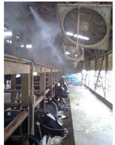
換気扇とミストによる暑熱対策を施した畜舎
