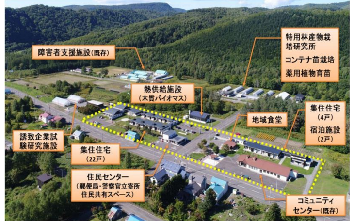
木質バイオマスボイラーによる熱エネルギーの利用例(下川町(一の橋バイオビレッジ))
