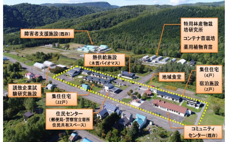
木質バイオマスボイラーによる熱エネルギーの利用例(下川町(一の橋バイオビレッジ))
