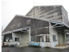
老朽化した施設
