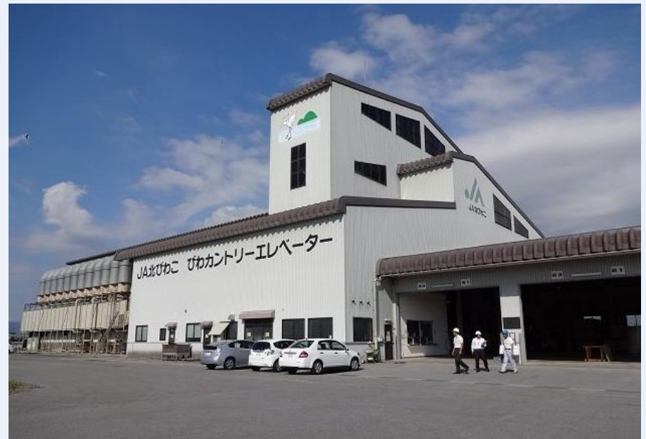
老朽化した既存施設
