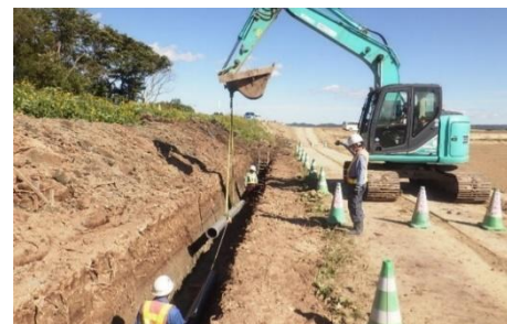
用水路工(管布設)
