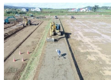
農道工(敷均し状況)
