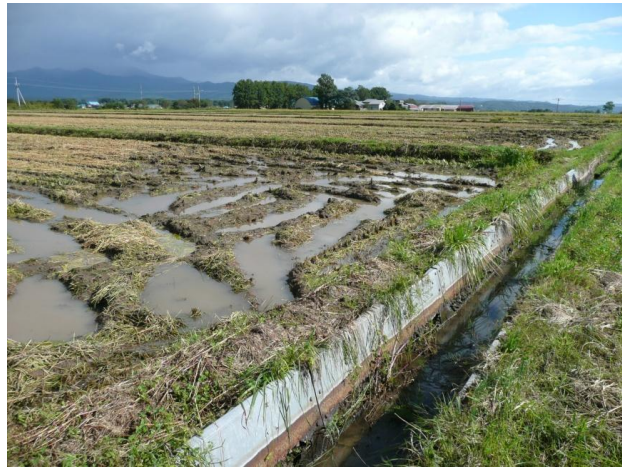
排水不良のほ場と老朽化した末端用水路 (腐食による水路破損) (南地区)
