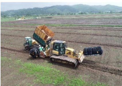
暗渠排水工(ベストドレーン)
