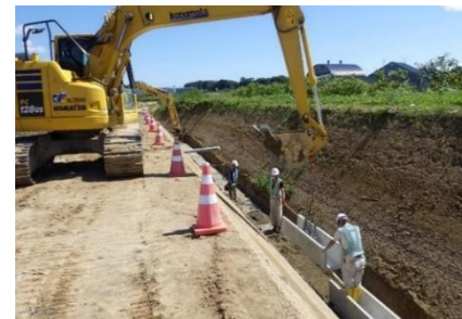
排水路工(トラフ布設)
