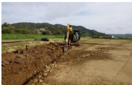
暗渠排水工(普通暗渠)
