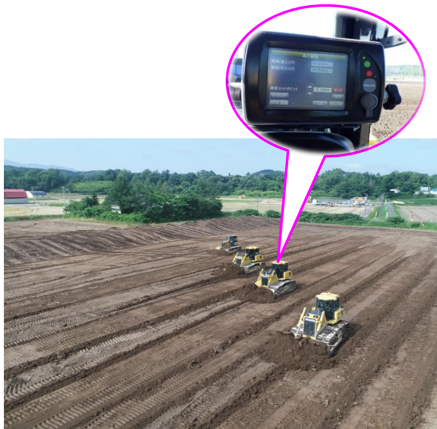
ブルドーザーによる整地作業
