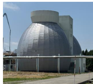
【汚泥の嫌気性発酵を行う卵形消化槽】
