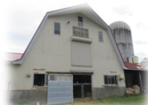
大切に残してくれた牛舎
