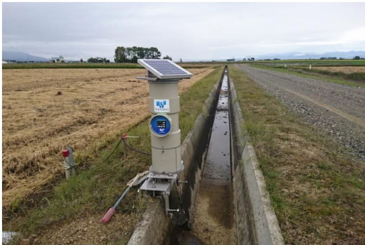
自動給排水管理システムにより、ほ場の見回りを軽減
