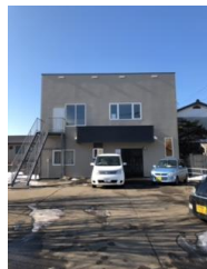
フードバンクくしろの外観
