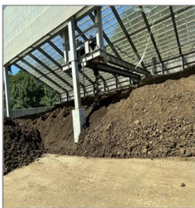
堆積発酵による処理 (コンクリートの上に積み上げただけ)
