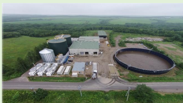
メタン発酵バイオマス発電
