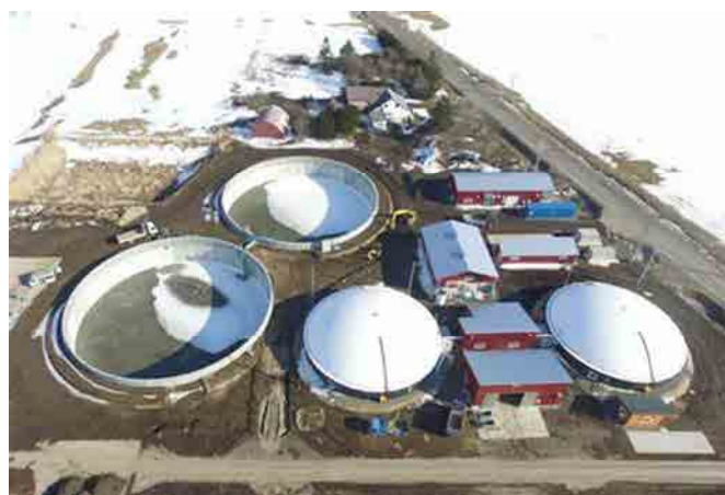
写真 2-3 個別型バイオガスプラント（㊤）
