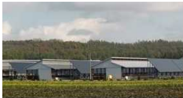
写真4 畜舎間の防疫上活用しない空き スペース活用の太陽光発電施設
