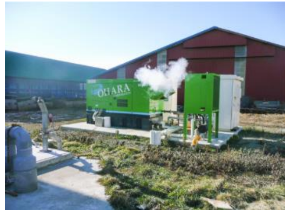
写真4 バイオガスプラントの発電機
