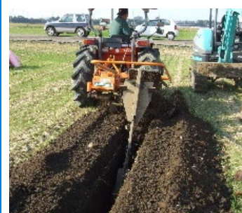
暗渠排水の整備
