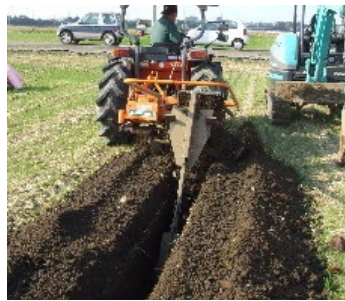
暗渠排水の整備
