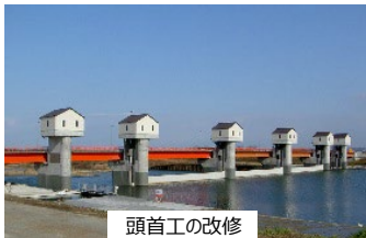
頭首工の改修
