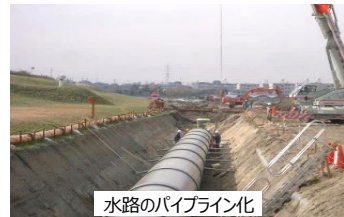
水路のパイプライン化
