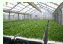
農業生産施設（水耕栽培ハウス）
