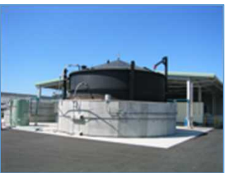
バイオガス発電
