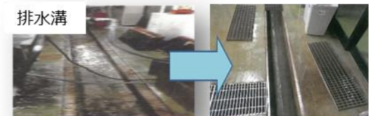
施設の衛生管理の強化に向けた排水溝、床、壁等の改修
