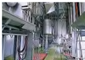
食肉解体施設
