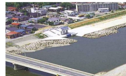
小千谷頭首工
