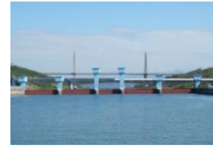
河北潟防潮水門
