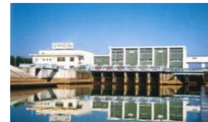
西部排水機場
