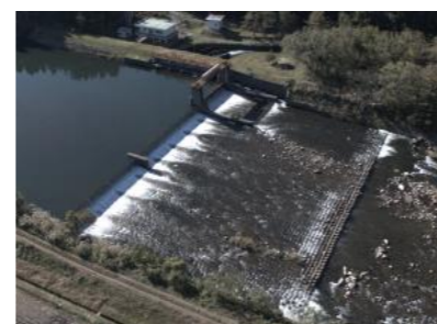
加治川第1頭首工
