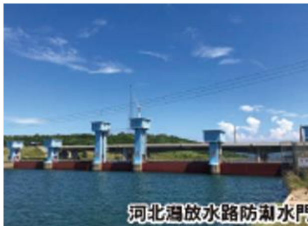
河北潟放水路防潮水門 (石川県河北郡内灘町)
