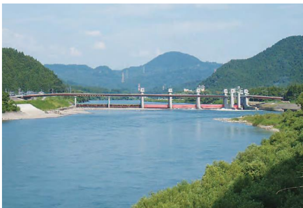
阿賀野川頭首工【新潟県阿賀野市】
