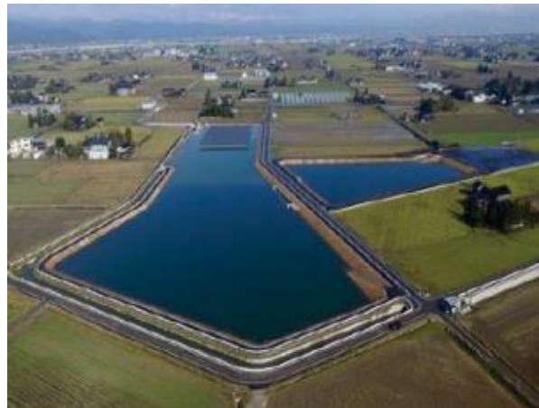
岸渡洪水調整池【富山県砺波市】
