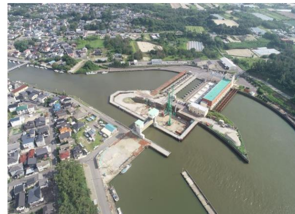
新川河口排水機場【新潟市西区】
