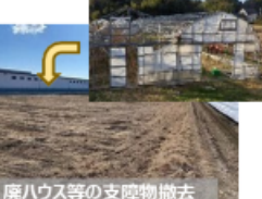
【荒廃農地の支障物撤去】
