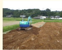
土層改良（客土）
