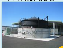
バイオガス発電
