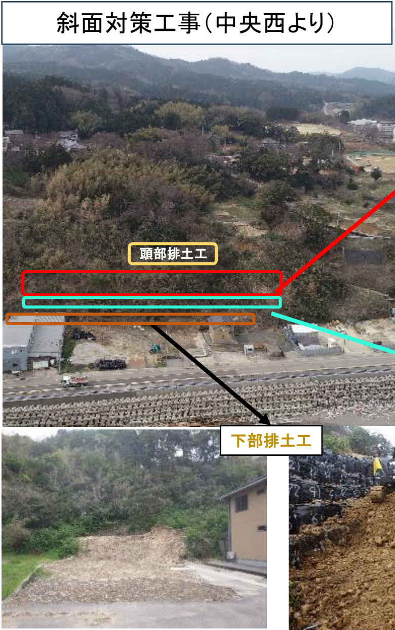
頭部排土工/下部排土工
