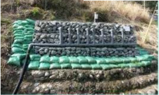
水抜きボーリング工
