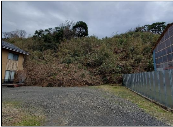
民家裏斜面崩壊
