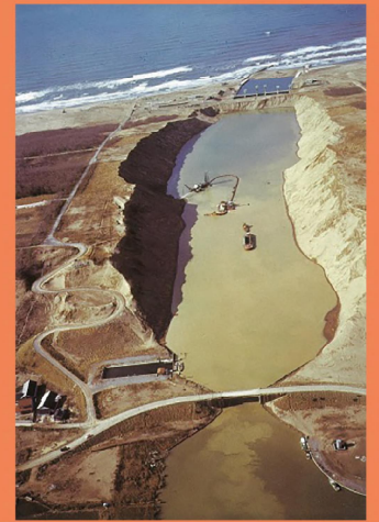
昭和45年の工事中の河北潟放水路 長さ1,670mの砂丘を掘削している様子
