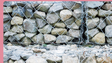
護岸は、石積みのカゴを配置して、水生動物の隠れ場所を作ります。
