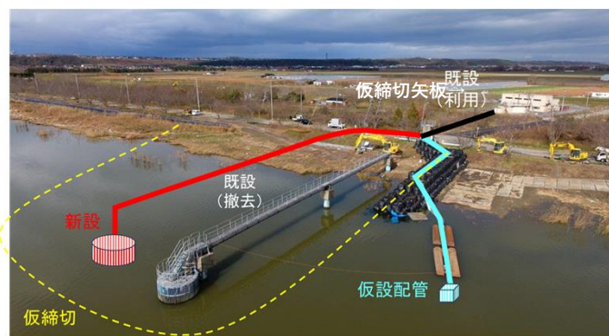
1 南部揚水機場における水管橋改修工事の概要
