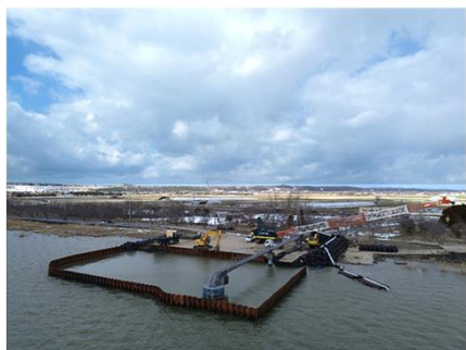
仮締切矢板打設状況 (令和7年2月撮影)
