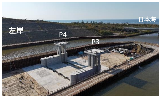
P3・P4堰柱における土木工事完了
