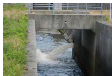
(写真右)→ ポンプ機から排水路へ放出される用水:
