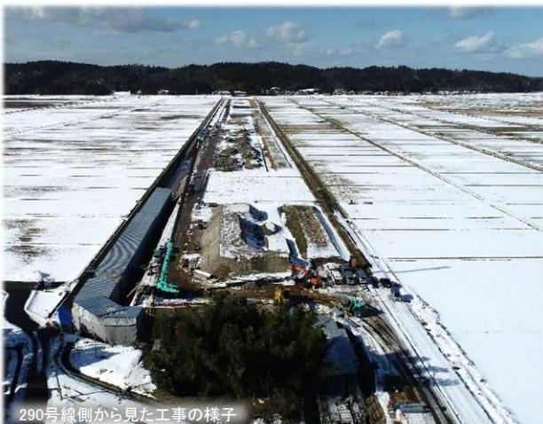
令和4年度は、開水路の敷設工事が法正橋沈砂池側から始まり、約0.8km区間の改修を行いました。
