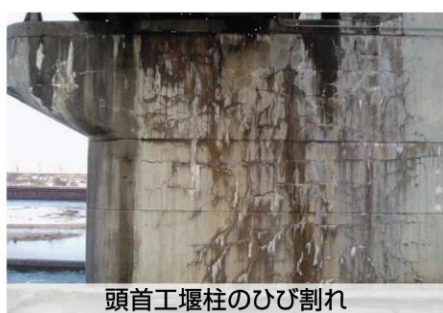
ダム制水ゲートの劣化
