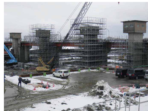
上流側施工状況
