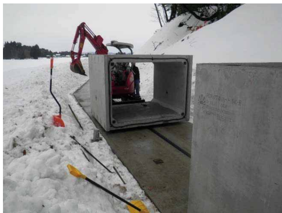
ボックスカルバート据付作業
