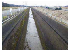
① 工事着手前
