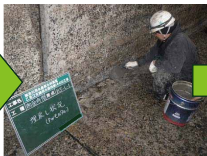
③ 欠損等の修復
