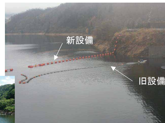
網場設置作業(既設網場撤去)
