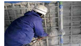
ポリマーセメントモルタル吹付状況
