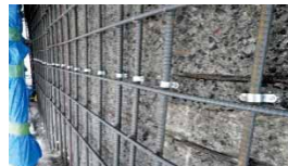
補強鉄筋組立状況
