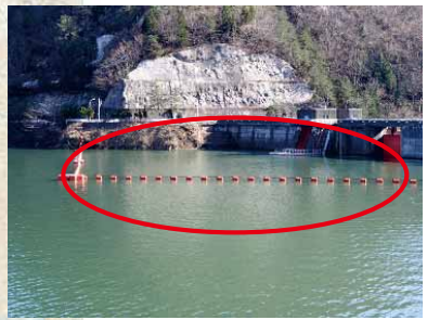
⑧内の倉ダム網場設備他改修工事
