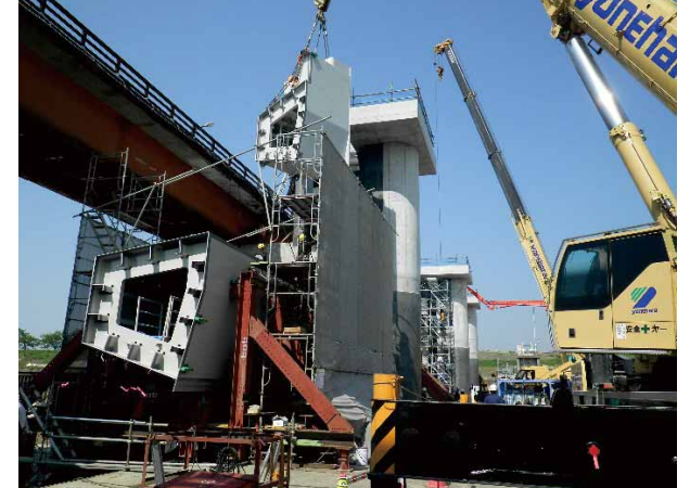
平成27年4月ゲート吊り込み状況
