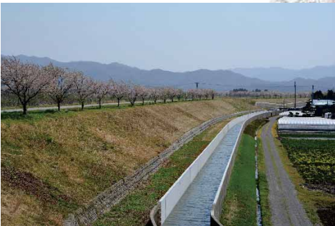
③④加治川第2頭首工左岸幹線用水路改修工事
