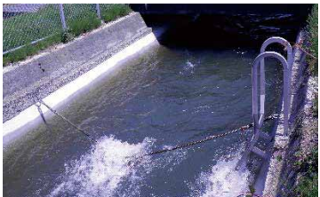
安全施設の設置状況
