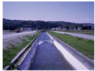
⑥⑦乙見江支線用水路改修工事
