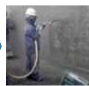
③モルタル吹付
