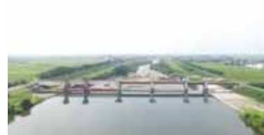
加治川第2頭首工全景(平成27年7月撮影)
