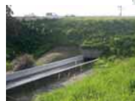
既設 第2号暗渠工部
