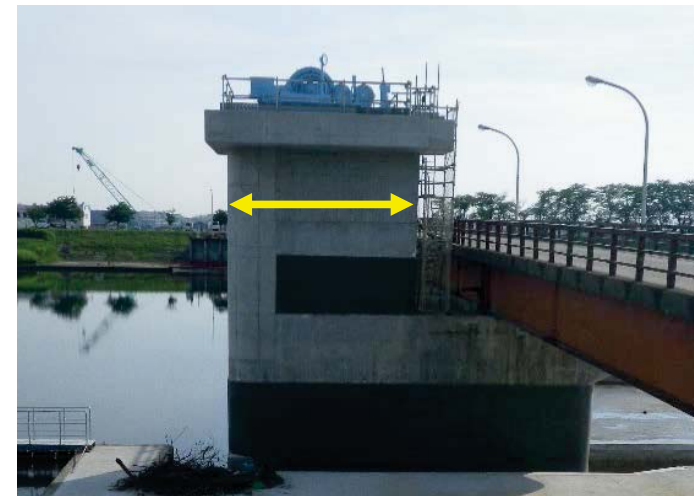
耐震化後の頭首工堰柱
