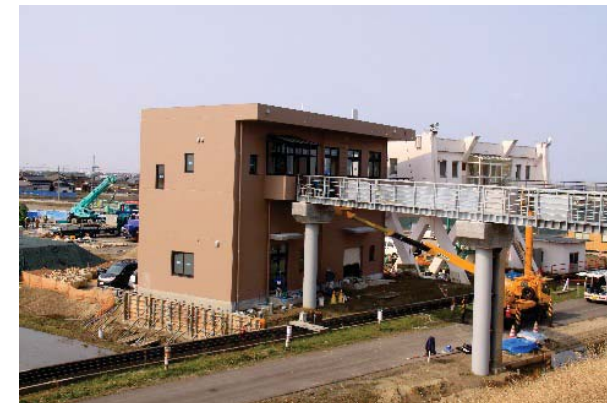
管理棟工事状況
