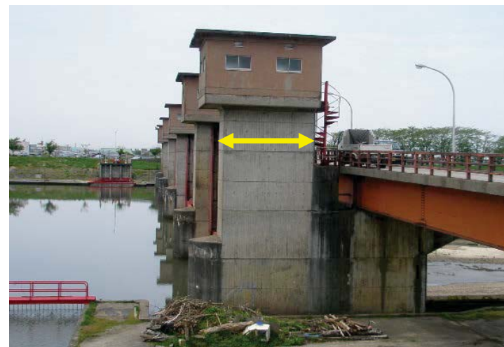
耐震化前の頭首工堰柱
