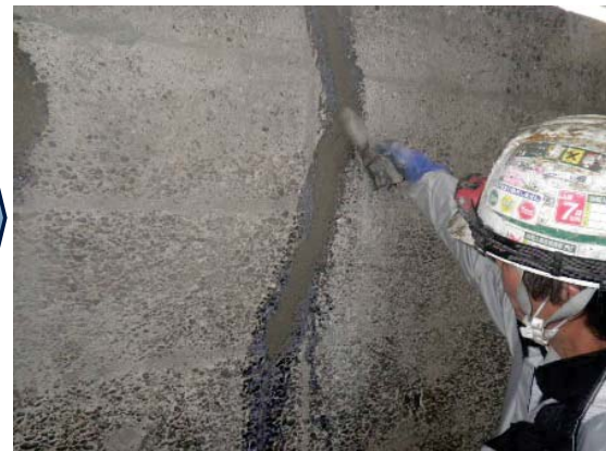
モルタル充填状況
