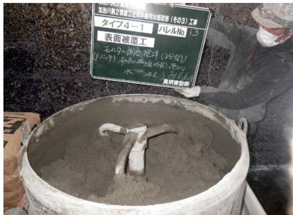
モルタル調合状況
