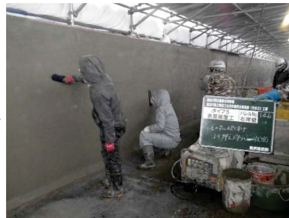
コテ仕上げ状況
