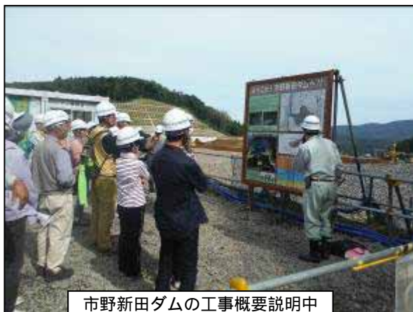
市野新田ダムの工事概要説明中
